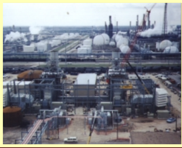
A.B.D'de 2 x 80-MW'lik kojenerasyon tesisi ▲
